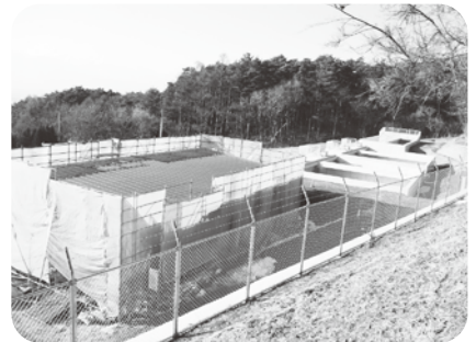
移設更新中の片丘浄水場
