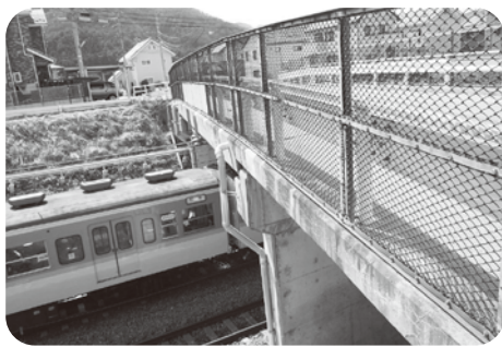
改修が始まる みどり湖駅跨線橋
