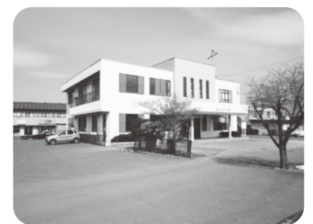
老朽化が進む広丘支所
