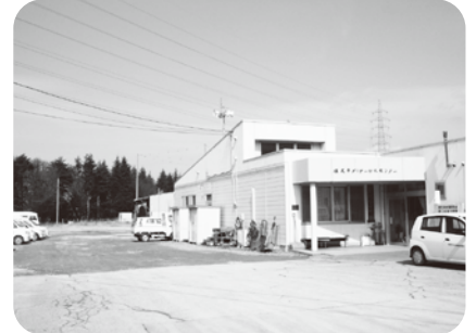
(仮称)ふれあいセンター広丘建設予定地
