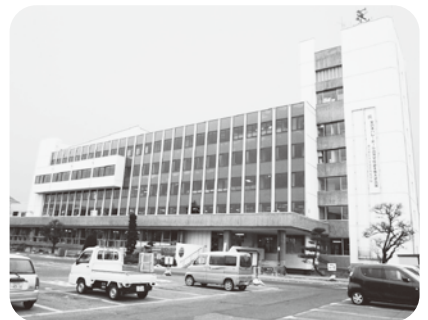
大規模改修予定の市庁舎
