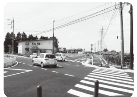
整備を進めている広丘西通線
