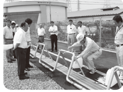
郷原の災害用仮設給水栓
