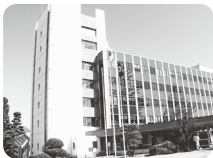
耐震補強のための調査・設計が始まる市庁舎
