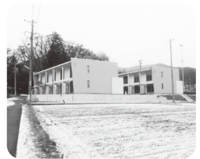
北小野地区若者定住促進住宅
