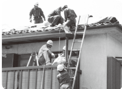
地震で被害を受けた屋根の修復作業
