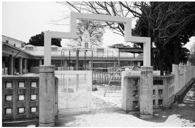
国道への接続道路も完成間近の宗賀中央保育園
