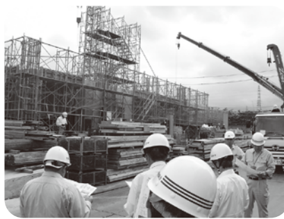
塩尻駅南地区再開発事業現場を視察
