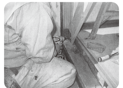
住宅耐震工事のようす
