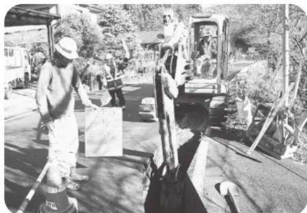
水道管工事現場
