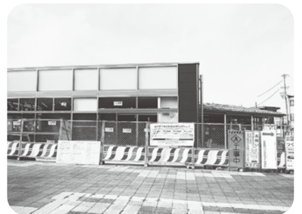
建設中の塩尻市観光センター
