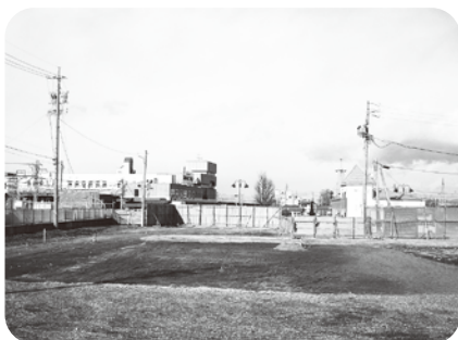
工事が進む駅南再開発ビル予定地
