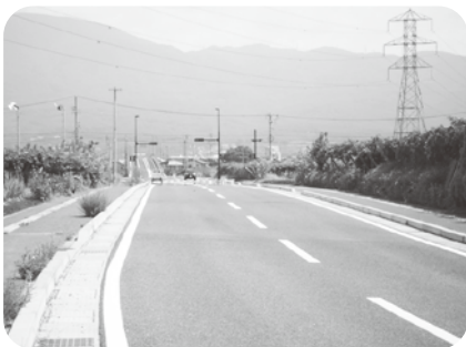
防犯灯設置が求められるげんば大橋西側
