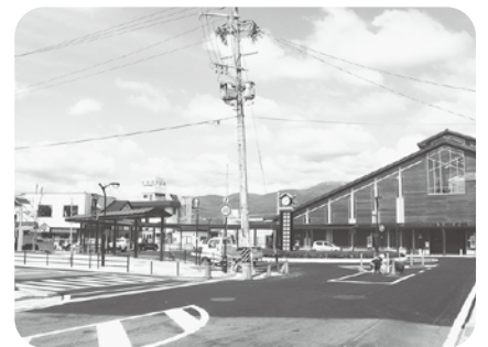
整備された広丘駅西口
