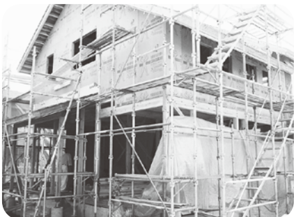
建築中のエコ住宅
