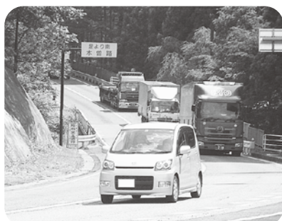
国道19号桜沢バイパストンネル予定地付近
