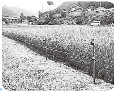
野生鳥獣対策の電気柵設置箇所
