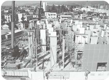
建設中の市民交流センターに設置する備品の取得について可決した
