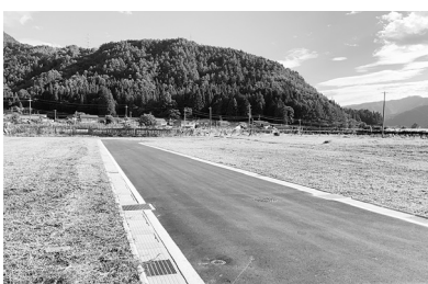
床尾区の宅地造成地
