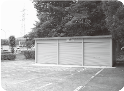
小坂田公園内に設置されている国土交通省の防災資機材備蓄庫
