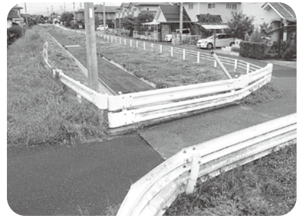
四ヶ堰上部に残る狭い橋 (広丘吉田)
