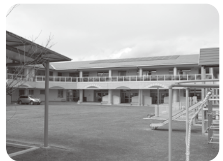
公共施設に設置されている太陽光パネル
