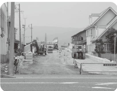
橋梁上部工事が進む 高校北通線
