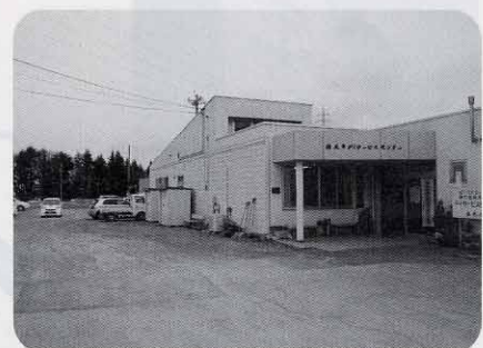
(仮称)ふれあいセンター広丘 建設予定地の旧桔梗荘跡
