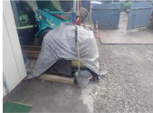
水タンクの設置
