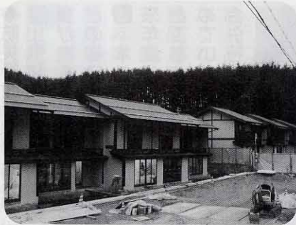
建て替えが進む市営住宅 床尾団地
