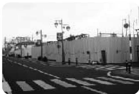
中心市街地活性化の核施設 「えん・ぱーく」建設予定地
