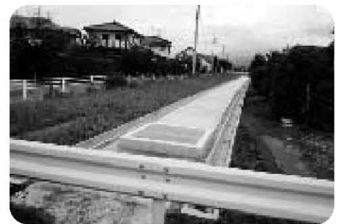
進む四ヶ堰改修工事
