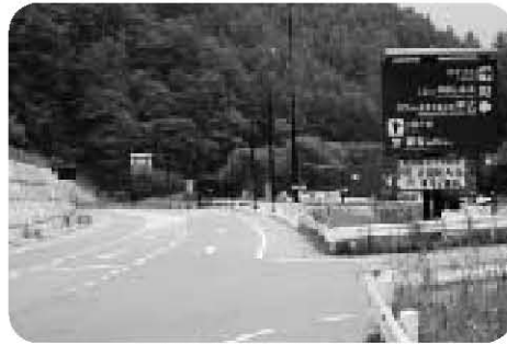
国道361号羽淵交差点
