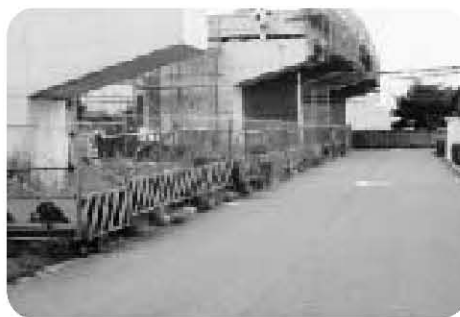
工事の進む高校北通線跨線橋
