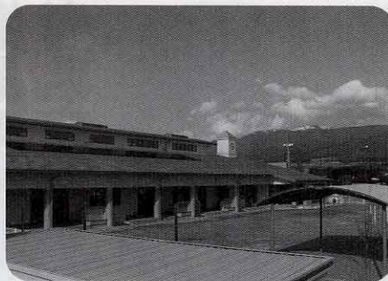
新たに建てられた高出保育園
