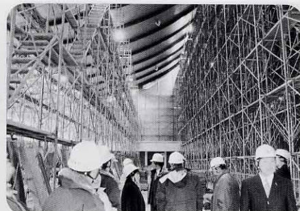
現市立体育館の耐震改修工事
