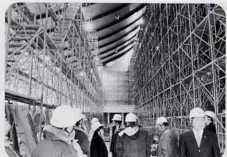
現市立体育館の耐震改修工事
