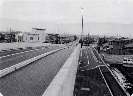
12月に開通したえびの子大橋 (広丘吉田)
