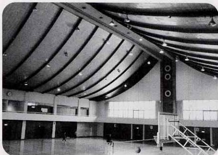
耐震補強工事を行う市立体育館
