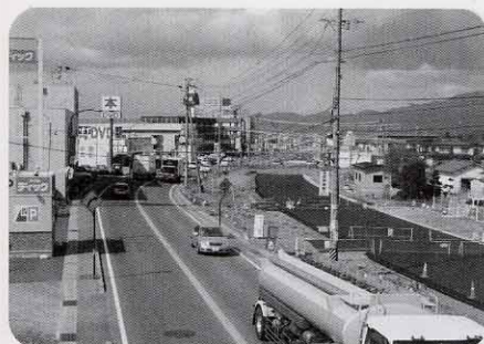
4車線化工事の進む国道19号 (広丘吉田)
