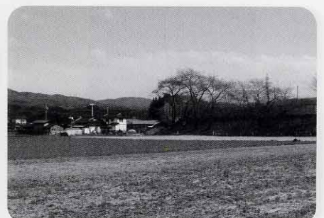
新高出保育園の建設予定地(市宮球場北側)
