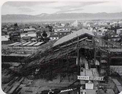
12月の供用開始に向け 工事の進むJR広丘駅
