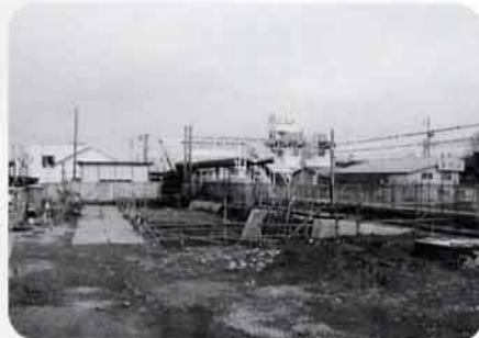
工事の進むJR広丘駅
