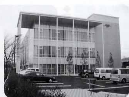
委員会終了後に視察を行った塩尻インキュベーションプラザ
