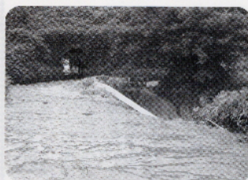
下西条 矢沢川被害 (7月19日)
