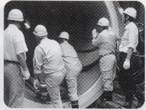
視察を行った雨水下水道工事 (広丘郷原)
