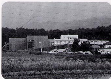
民間活力での整備が進む特養施設
