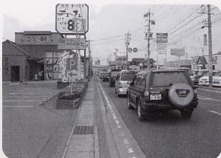
早期拡幅が期待される 国道19号広丘駅付近
