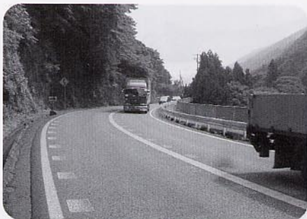
迂回路のない国道19号 費川桜沢地籍
