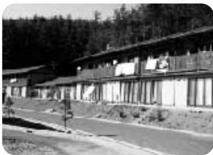
建替えられた市営住宅床尾団地
