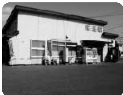
新駅舎着工予定の現広丘駅舎
