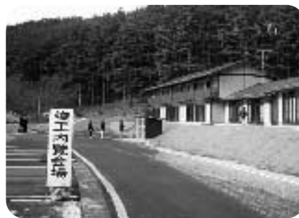
第一期工事が完成した床尾団地
