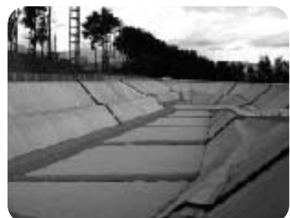
完成した最終処分場
