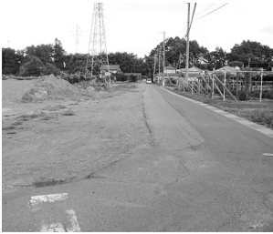
湯之氣の坂下の市道の砂利道部分
