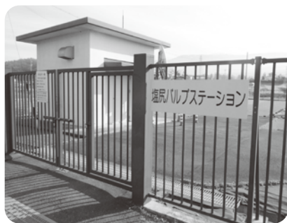
都市ガス塩尻バルブステーション
